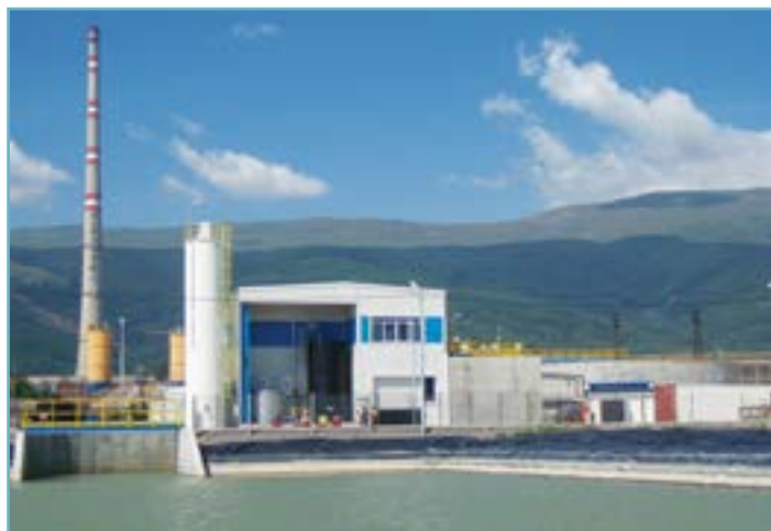
Пречиствателната станция за дъждовни води в Аурубис, изградена от ЕнвигоХеми България
