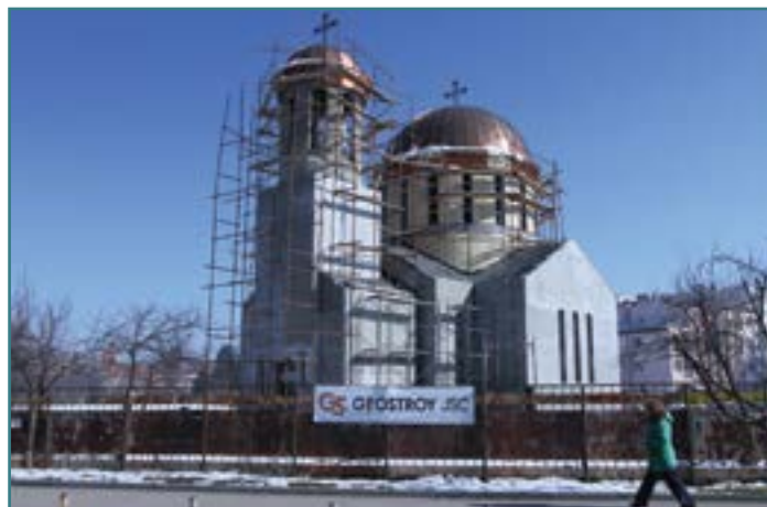
Построената църква в ж.к. Младост от Геострой АД .
